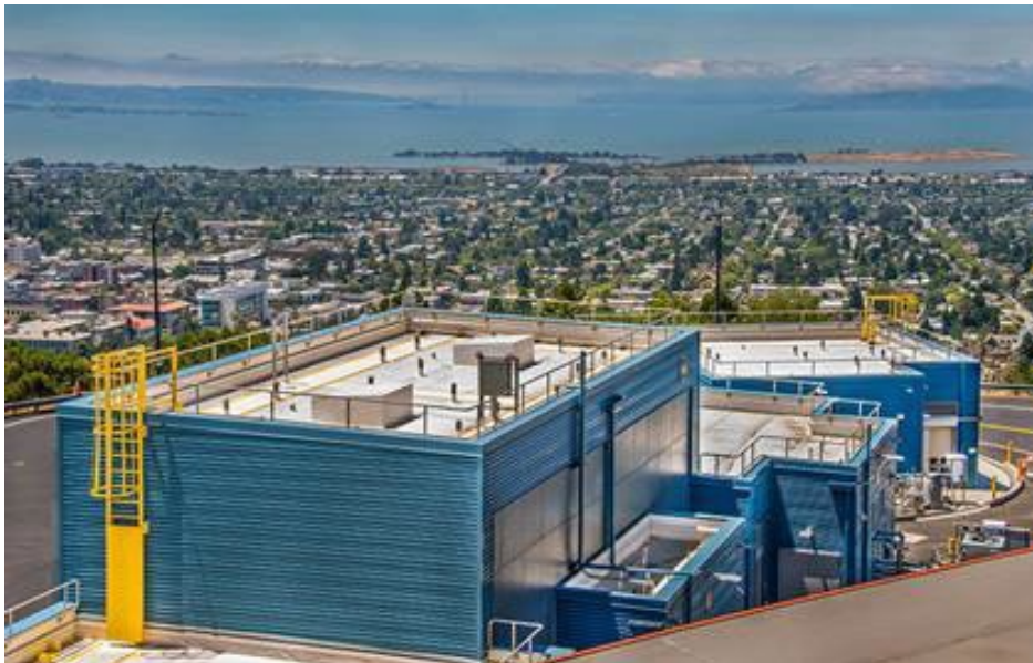
LBNL FLEXLAB Test Site
